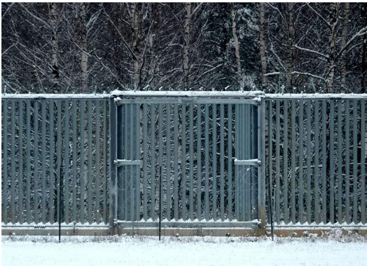
Przejście dla zwierząt w ostoi żubrów koło Starego Masiewa. Concertina na zdjęciu jest słabo widoczna, podobnie jak zabezpieczająca ją siatka leśna
